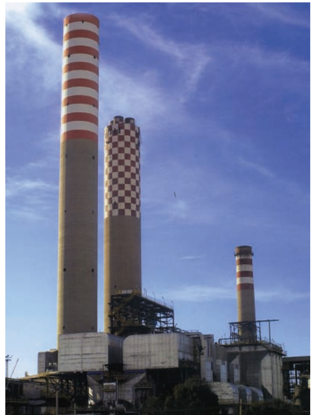
Foto archivio impianto di Gela
