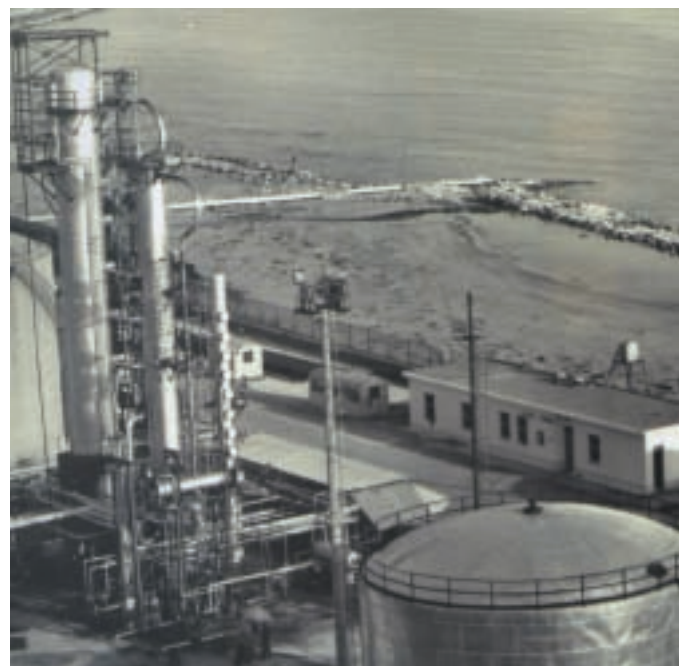
Foto archivio impianto di Gela
