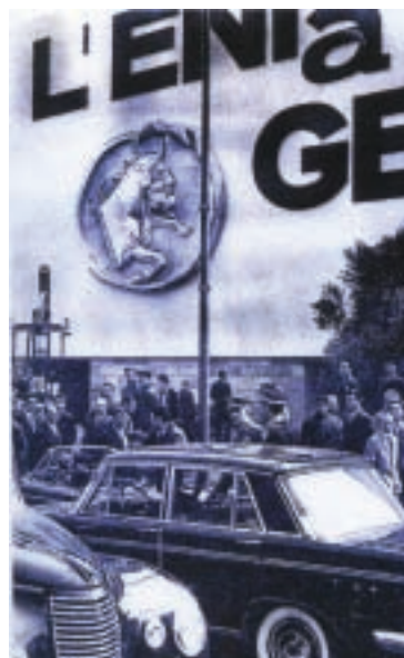
Foto archivio impianto di Gela
