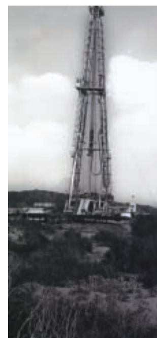
Foto archivio impianto di Gela
